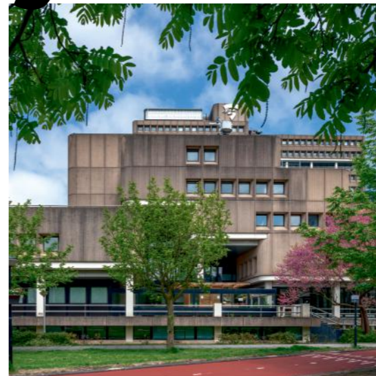
KANTORENCOMPLEX LEEUWENBURG, AMSTERDAM (1977)
